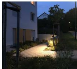
Abb. 14 und 15: Gute blendfreie und flächige Ausleuchtung bieten voll abgeschirmte Pollerleuchten. Studentenwohnheim in Fulda. Fotos: Sabine Frank.
