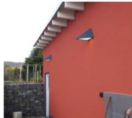
Abb. 16: Wandleuchten, voll abgeschirmt, 2700 Kelvin mit breitflächiger Lichtverteilung durch entsprechende Optiken und Reflektoren und Funksteuerung statt Bewegungsmelder. Foto: Sabine Frank.
