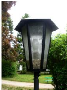
Abb. 2 Insekten tot an Leuchtkörpern: Der untere Leuchteil ist mit Insekten gefüllt, die hier zu Tode kamen. Durch Wahl einer entsprechenden Schutzklasse (IP 65) kann dies vermieden werden. Foto: Conrad Fink
