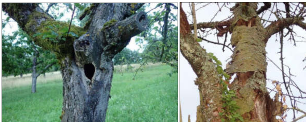
Abbildung 15: Baumhöhle in einem Apfelbaum (linkes Bild) sowie abgeplatzte Rinde eines Kirschbaums (rechtes Bild).
