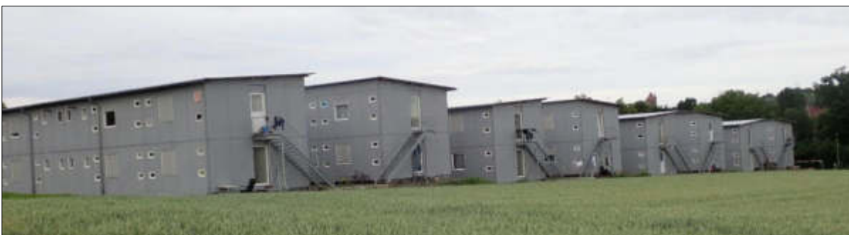
Abbildung 21: Gebäude mit geringem Potenzial für gebäudenutzende Vögel und Fledermäuse innerhalb des Untersuchungsgebiets.
