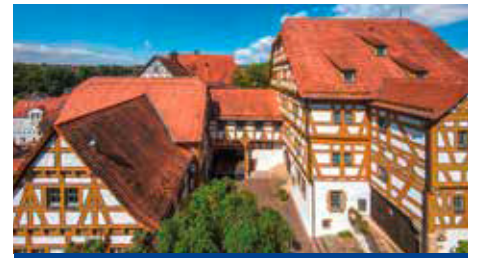
Fachwerkführung Altstadt Bietigheim
